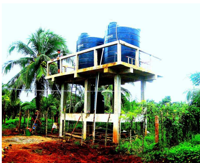
Nouveaux réservoirs d'eau construits à Wawashang
